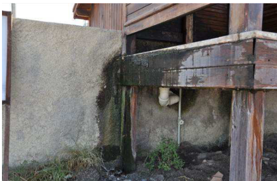
Fig. 8: Drainpipe was installed on the promenade shower in 2013 Abb. 8: 2013 wurde ein Abflussrohr an der Dusche montiert (Foto: M. Stachowitsch, 2013)
