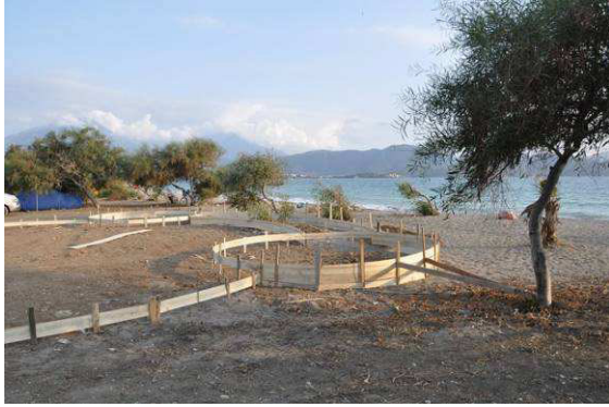
Fig. 21: Wooden frames for cementation of new establishment, Çiftlik Abb. 21: Holzrahmen für Betonierung von einem neuen Gebäude, Çiftlik (Foto: M. Stachowitsch, 2014)
