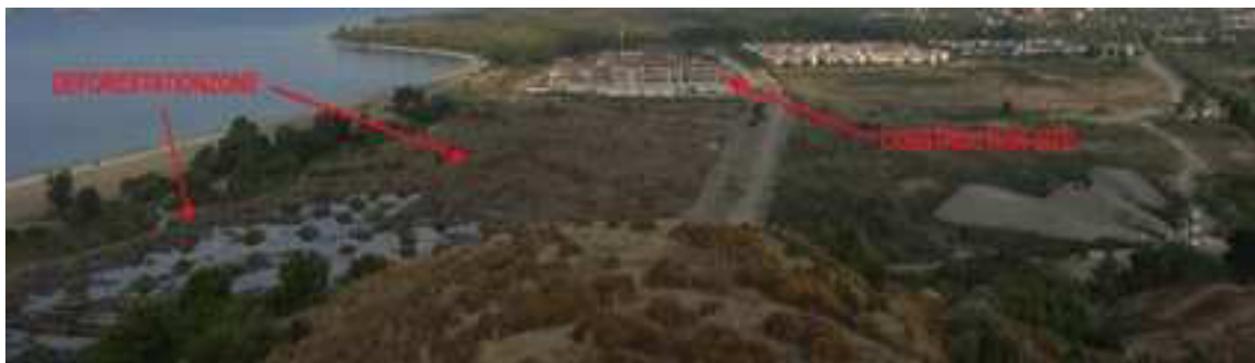
Fig. 63: View from the hill revealing the huge construction site and deforestation zone (Photo: M. Herzog) Abb. 63: Blick vom Hügel um das Ausmaß der Baustelle und Rodungszone zu sehen
