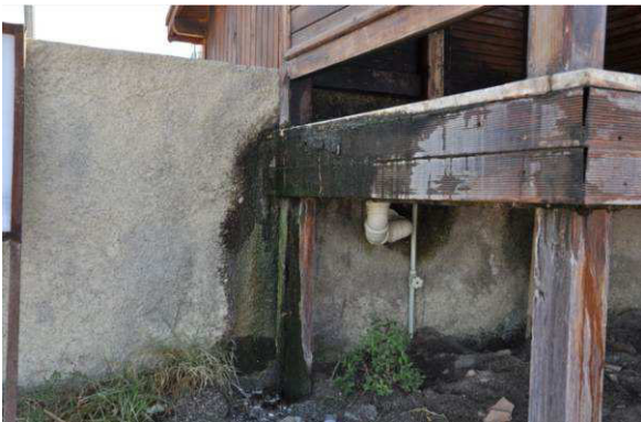
Figure 2: A new drainpipe was installed on the promenade shower Abbildung 2: Ein neues Abflussrohr wurde an der Dusche montiert (Foto: M. Stachowitsch)
